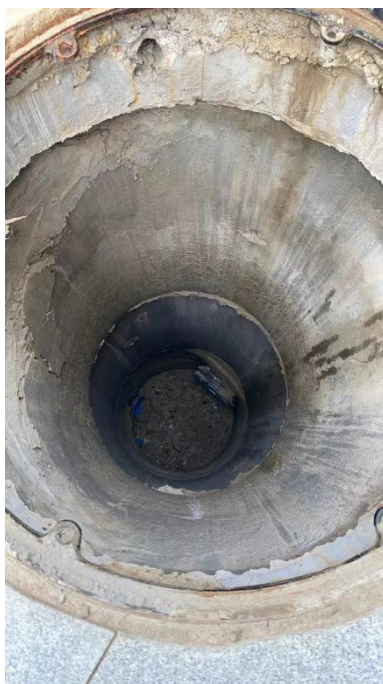
厂区污水总排口现状图
