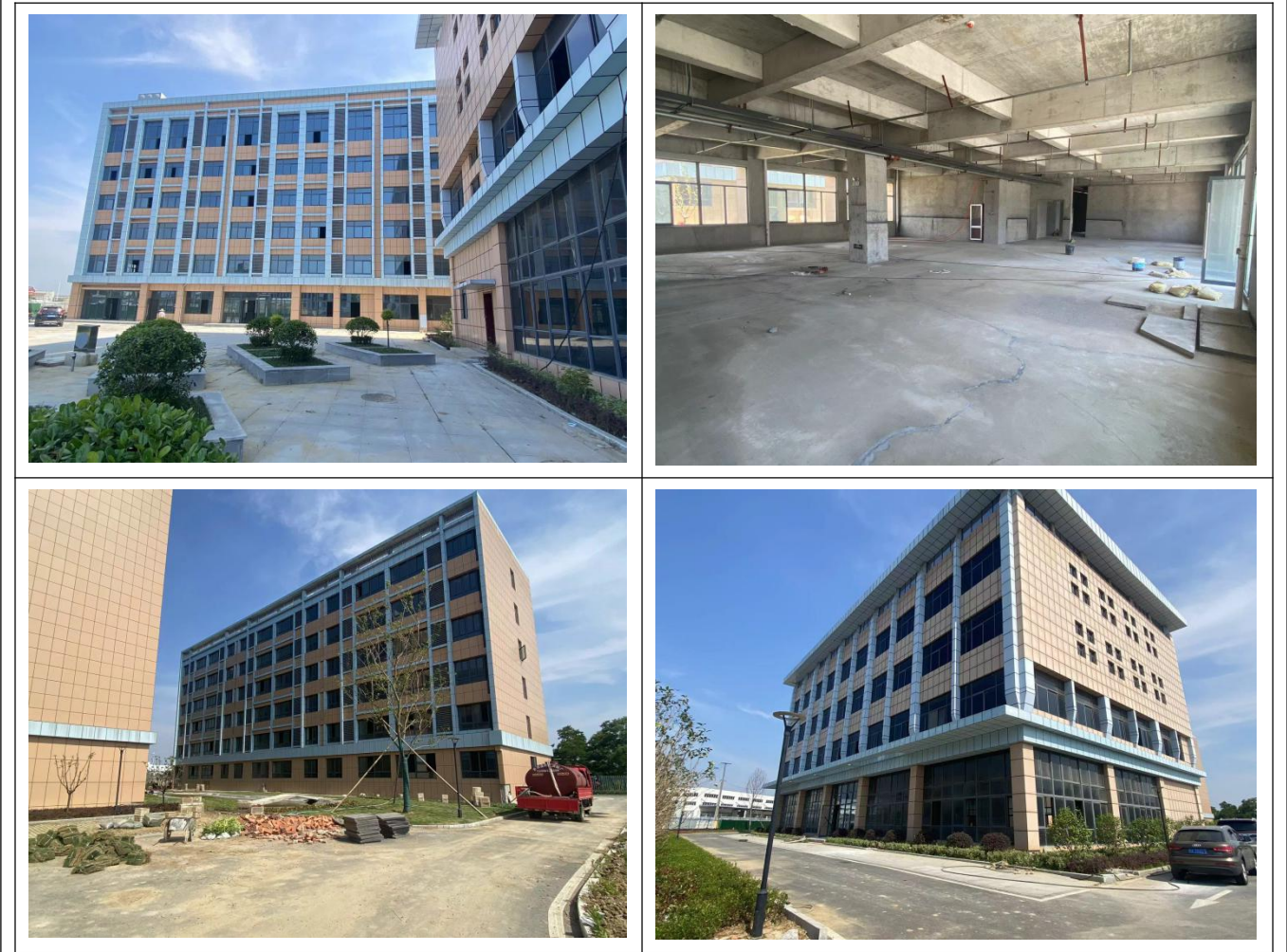
厂区实际建设图示如下：
